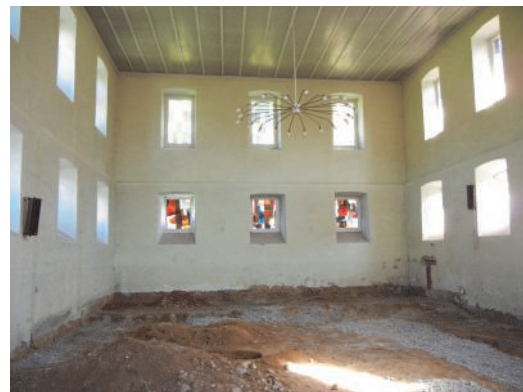
Aktueller Stand der Renovierungsarbeiten
